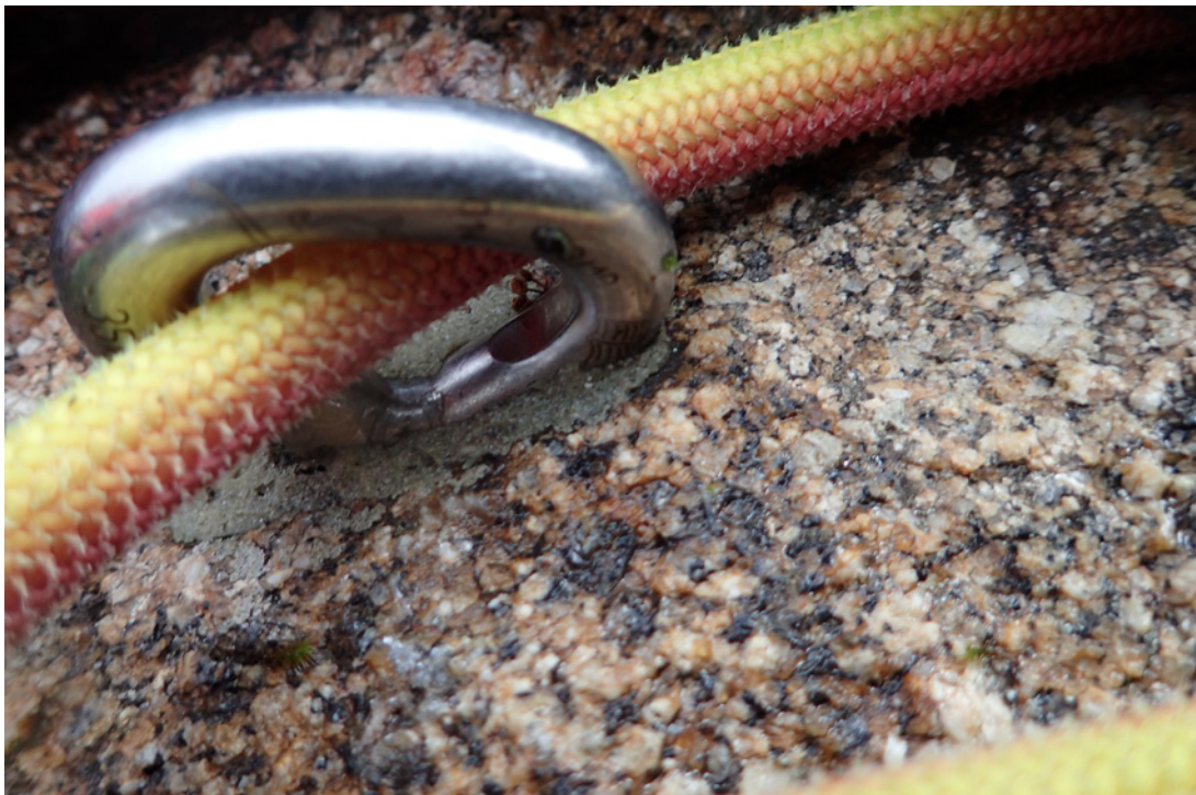
Detalle del desgaste del tensor químico primario.
